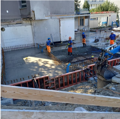
Coulage de la dalle du 1er étage
