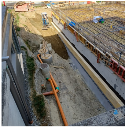
Préparation de la dalle sur le sous-sol
