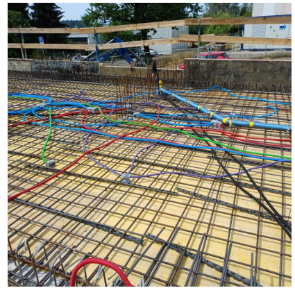
Préparation de la dalle sur le sous-sol
