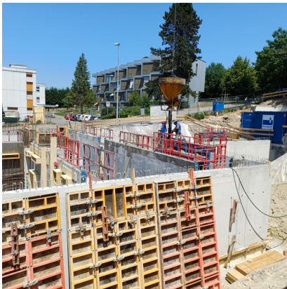
Montage des murs du sous-sol
