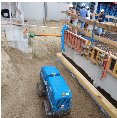
Montage des murs du rez-de-chaussée
