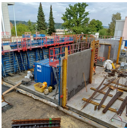
Montage des murs du rez-de-chaussée
