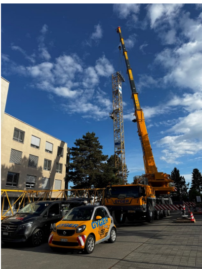
Le 08.05.2026 : montage de la grue dotée d'une flèche de 60 m !
